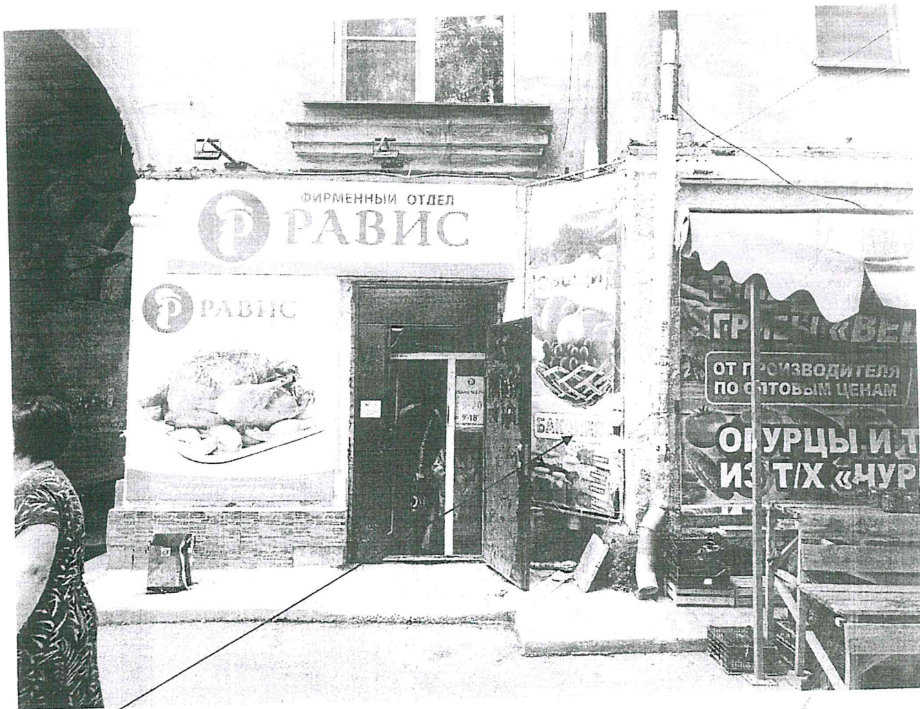
Рекламная конструкция из баннерной ткани на фасаде жилого помещения, нарушение п.п.1 Пункта 24 Правил
